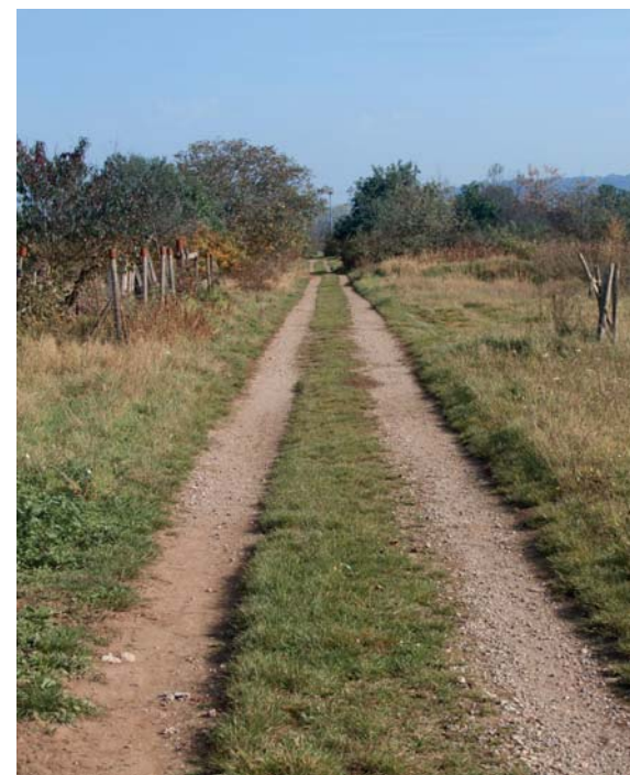
Der Weg vor dem Einsatz des Planierhobels
